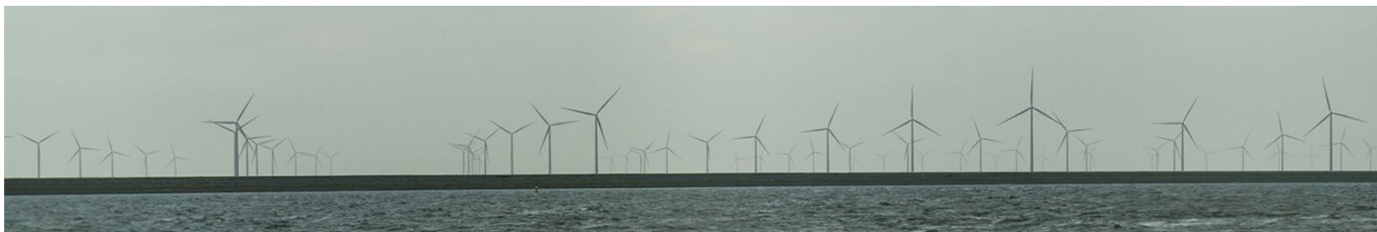
Visualisatie van het in aanbouw zijnde windpark Fryslân. Dit park zal een waarschijnlijk een impuls geven aan meningsvorming over opstellingen van windenergie.
