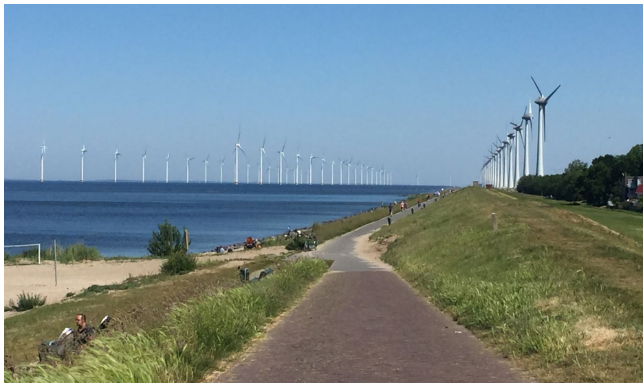
Grootschalige opstelling: windpark Noordoostpolder, gezien vanaf Urk. Op een aangename feestdag wordt er druk gewandeld langs het windpark. (foto: F. Stroeken)
