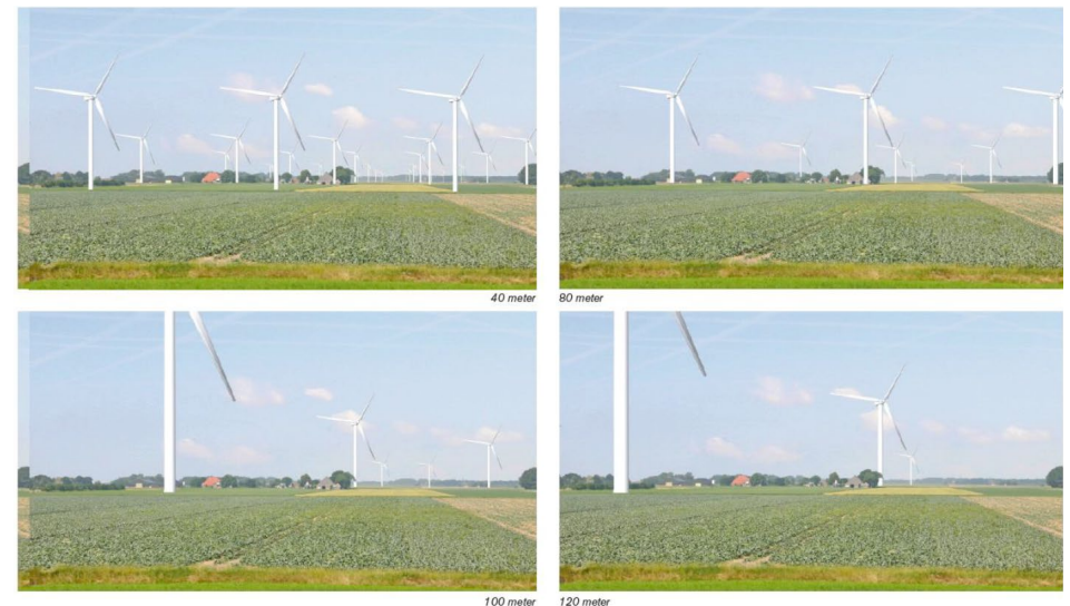
‘Constance ruimtevraag’: in alle vier de beelden wordt evenveel energie opgewekt. Respectievelijk met masten van 40m, 80m, 100m en 120 meter. Bij grote hoogte ontstaat een rustiger beeld. (Visualisatie Witteveen en Bos).
