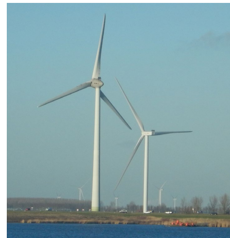
Links. Op de achtergrond 1 turbines met een zeer lage tip (foto J.H. van den Hamer). Rechts een tiplaaft van 20m bij een rotordiameter van 120 meter. Zo'n tiplaaft komt indringend dicht bij mensen op de grond.
