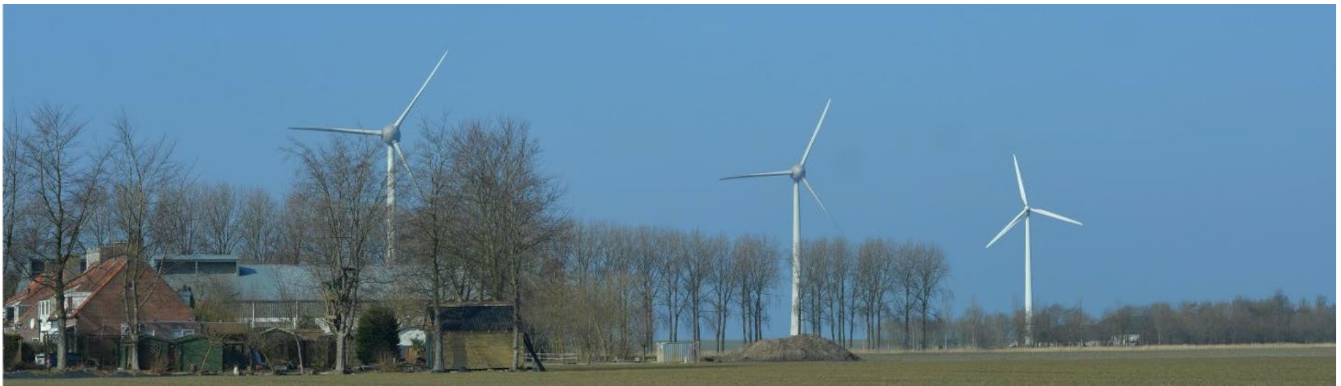
Welke turbine is hoger? De rechter heeft een tip van 98 meter en de linker 2 hebben een tip van 198 meter. Situatie te Urk. (foto: Marc van Grieken /MVGLA)
