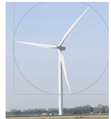
Links. Op de achtergrond 1 turbines met een zeer lage tip (foto J.H. van den Hamer). Rechts een tiplaaft van 20m bij een rotordiameter van 120 meter. Zo'n tiplaaft komt indringend dicht bij mensen op de grond.
