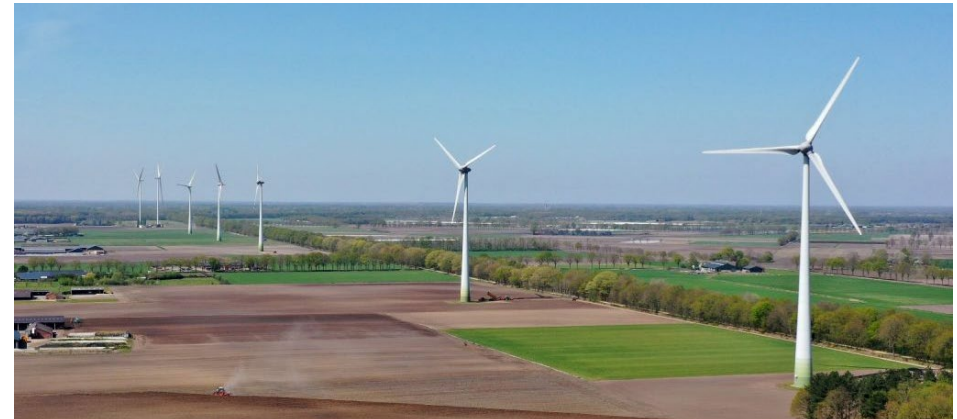
Vijf turbines met ashoogte 90m en twee recent toegevoegde turbines met een ashoogte van 130 meter en met ruimere afstand ertussen. Hier ontstaat een wat rommelige lijnopstelling. Heibloem, Limburg (foto van www.zuidenwind.org ).
