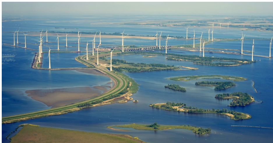
Windpark Krammer. Relatie tussen dammen en het patroon dat gevormd wordt door turbines is niet helder. Toch is hier onmiskenbaar sprake van een krachtig cluster dat een landschappelijke identiteit vormt. (foto Johan Meeus)
