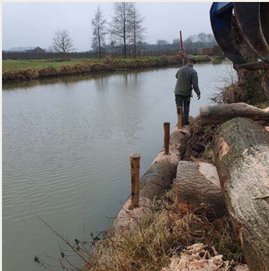
De stammen zijn voor de stevigheid doorboord met palen. Foto: Klaas de Boer.
